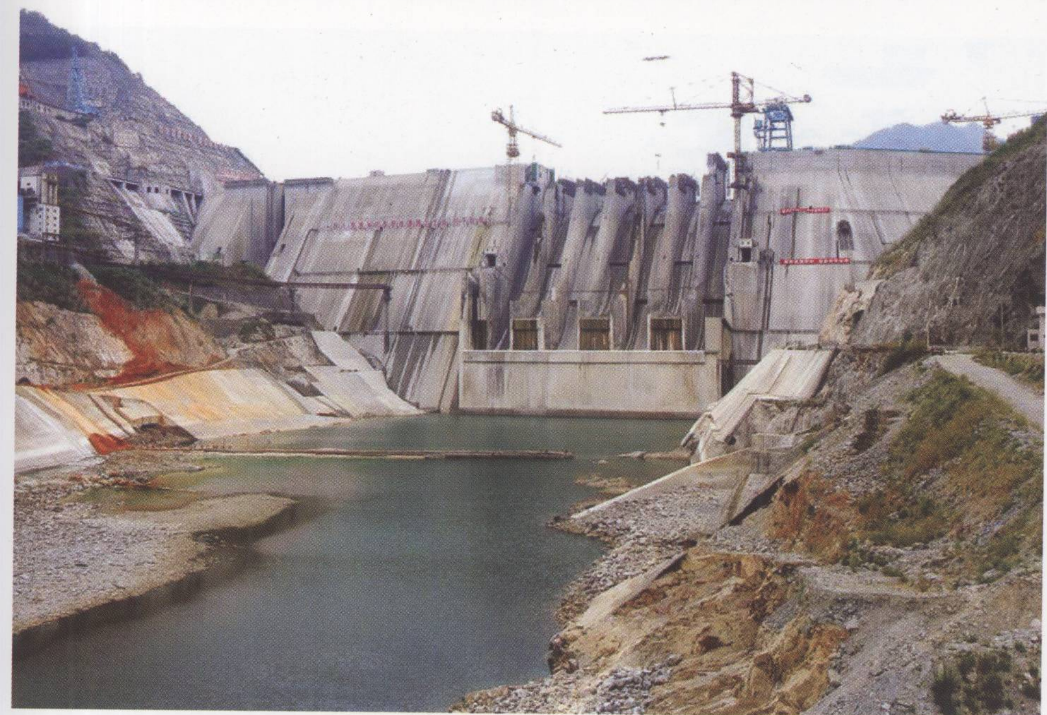
正在建设中的中国第二大水电站——龙滩电站（李桐 摄）
