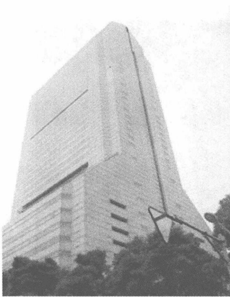
图 1-5 日本 NEC 大楼
