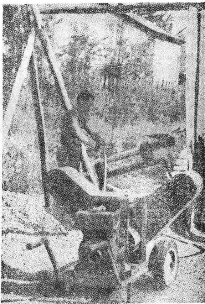
图17. 工作状态的《DEMAILLET》型銑刀剥皮机
