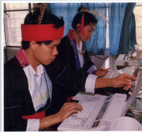
县邮电局程控 机房 ▶
