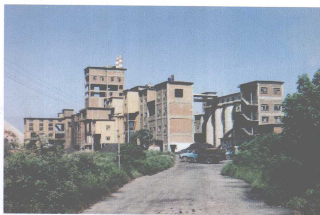
合山市水泥厂厂房一角
