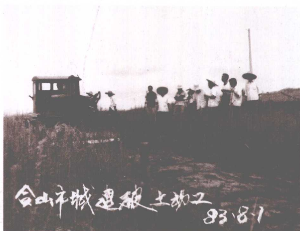
1983年8月1日合山市城市建设 破土动工
