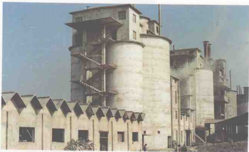
在灵川县大圩镇财政所扶持下发展起来的铁山水泥厂。
