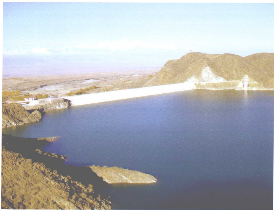
水利枢纽工程——鄂托克赛尔水库
