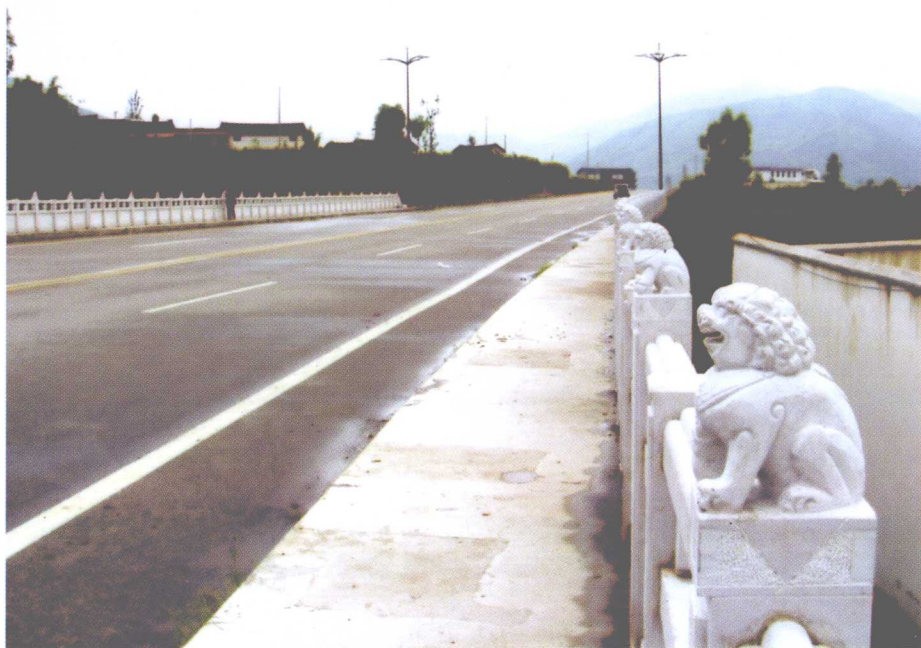
新修的巍南二级公路
