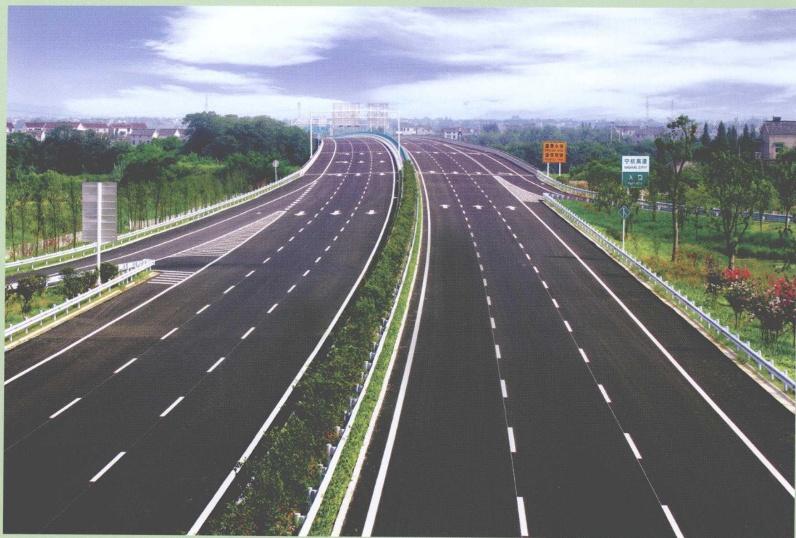
▲ 宁杭高速公路
