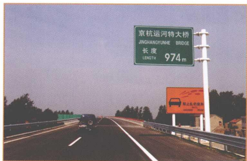
▲ 京杭运河特大桥
