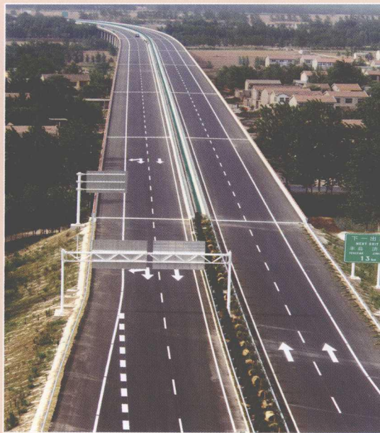
▲ 跨陇海铁路特大桥
