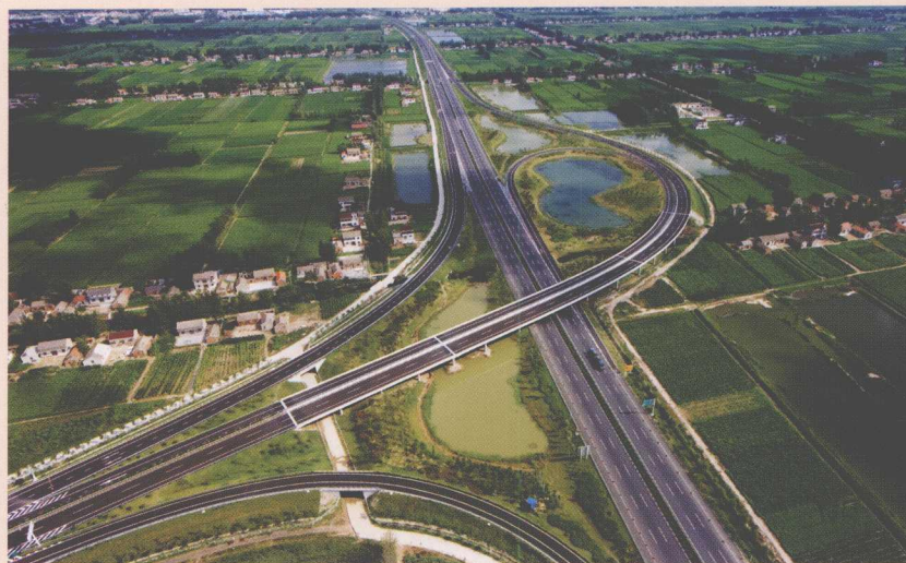
▼ 通榆河特大桥
