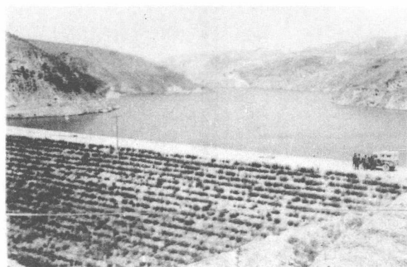
照片33 黄土丘陵区水库一角
