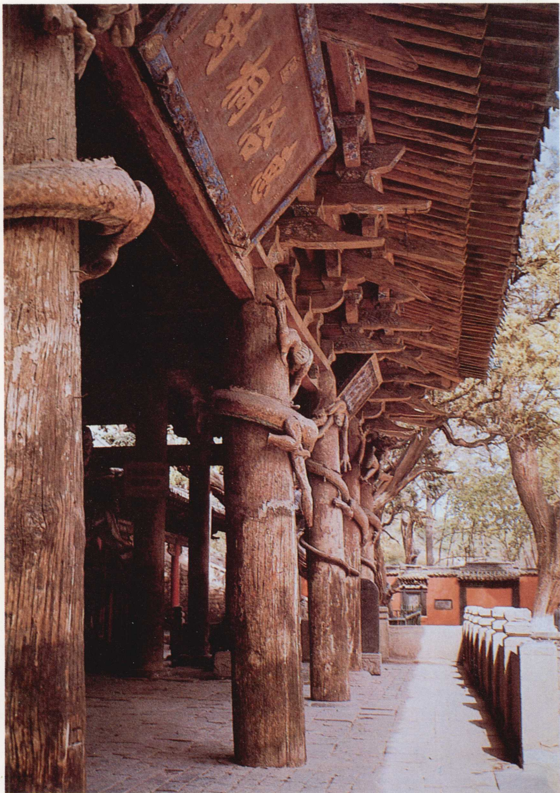
太原晉祠聖母殿的斗拱， 使用昂材，造成碩大雄奇 的力學美感。
