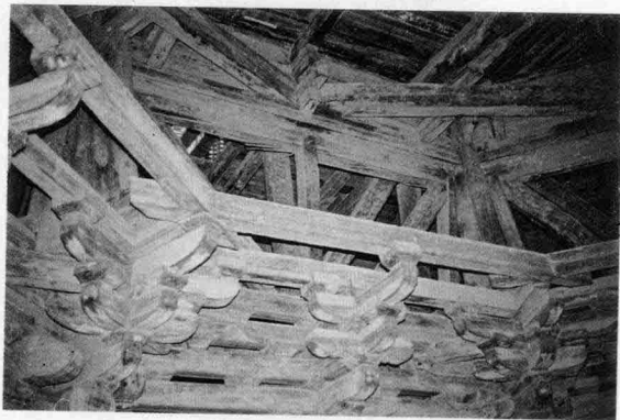
▲山西应县佛宫寺释迦塔内部构架。
