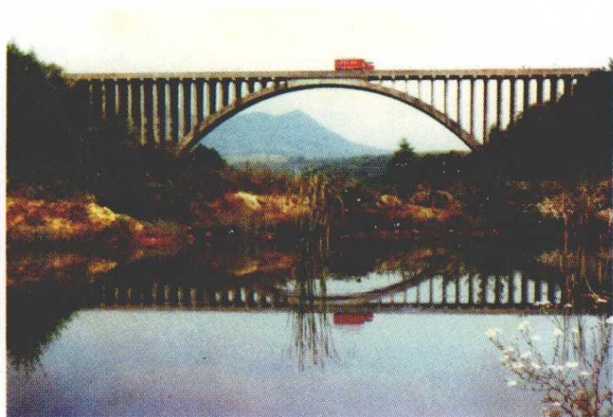
宽甸蚂蚁沙大桥
