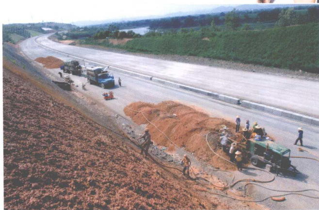
广西百色又一条建设中的公路
