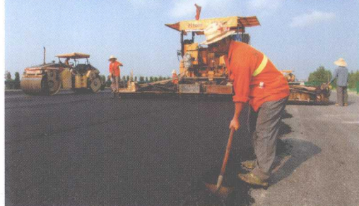
施工人员冒着高温酷暑在大别山修建高速公路
