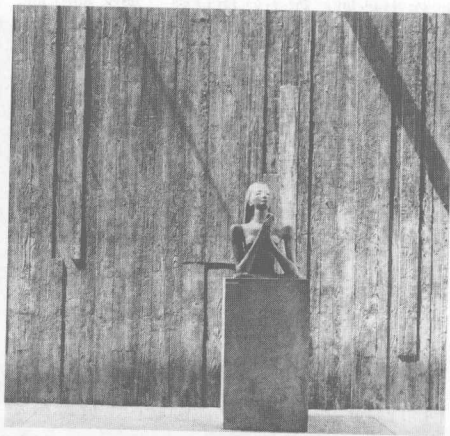
图 1-29 留有清晰木模板印痕的清水混凝土墙面
