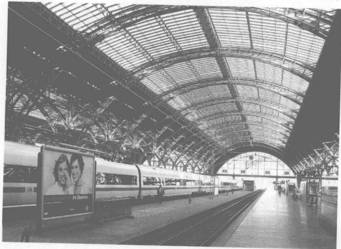
图 1-12 钢结构屋顶技术，是 人类空间技术的一次 飞跃，这是欧洲火车 站常见的钢结构的巨 大的采光屋顶
