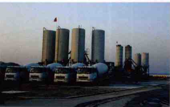
钦州港发电厂浇灌工地
