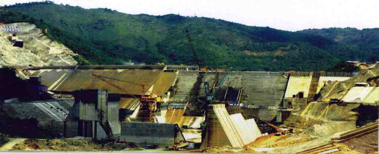
施工中的百色水利枢纽
