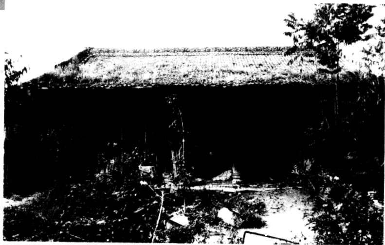
石堡杨素蕴故居南府存留大厅
