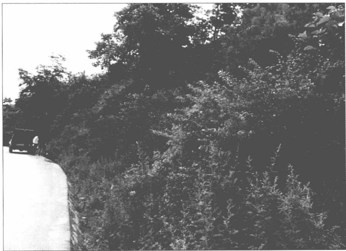
自然恢复 80 年后的公路边坡植被群落 (西南地区)
