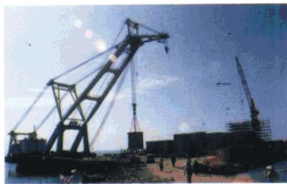
紧张施工中的和邦国际工业港
