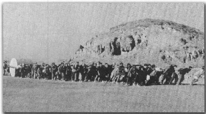
柳州民众在修筑柳州机场。
