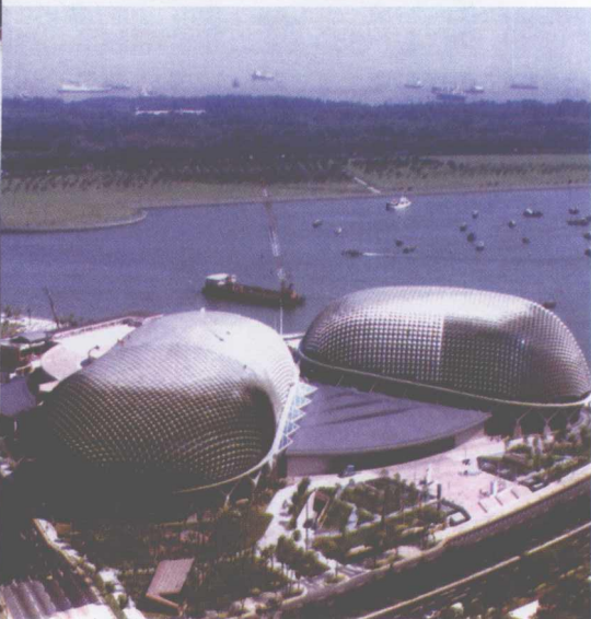
▼ 位于新加坡河口的滨海艺术中心，屋顶钢玻璃结构，被喜称为“榴莲壳”
