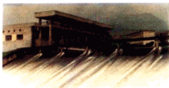
蕉岭县大力发展小水电，水力资源开发率达 90%。图为装机 5000 千瓦的艾坝低水头电站
