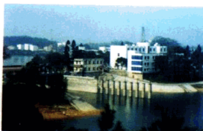
鹤地水库渠首风光
