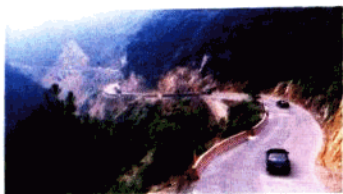
图为竣工通车的蕉（城）北（礮）公路
