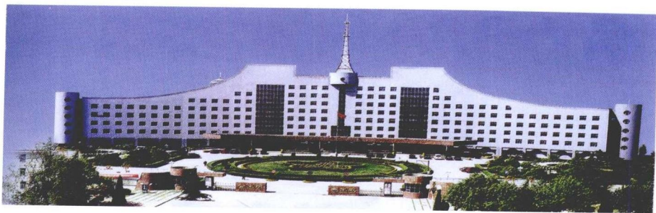
市政府办公大楼
