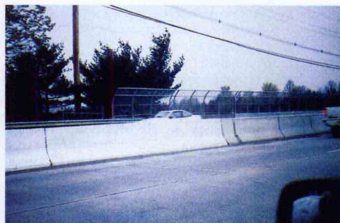
图7 用白色的混凝土制作的道路中央路障可以改善道路的可视性并增强安全性
