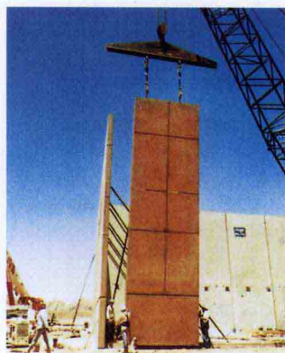
图5 立墙平浇施工不仅速度快,其饰面处理工艺也很简单
