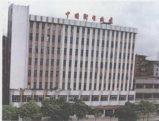
梧州卫生检疫局办公楼
