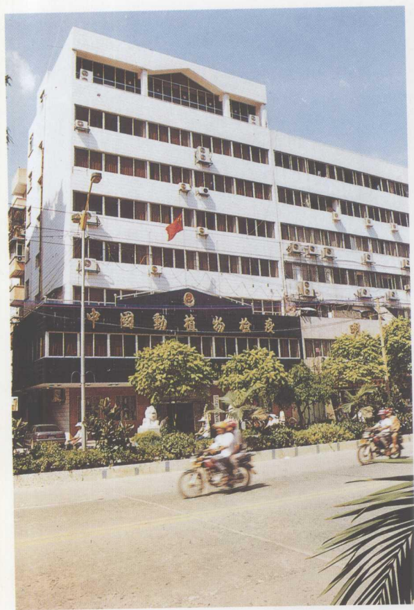
梧州动植物检疫局办公大楼
