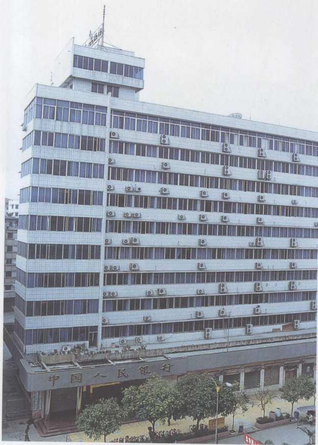
人民银行梧州市中心支行办公大楼
