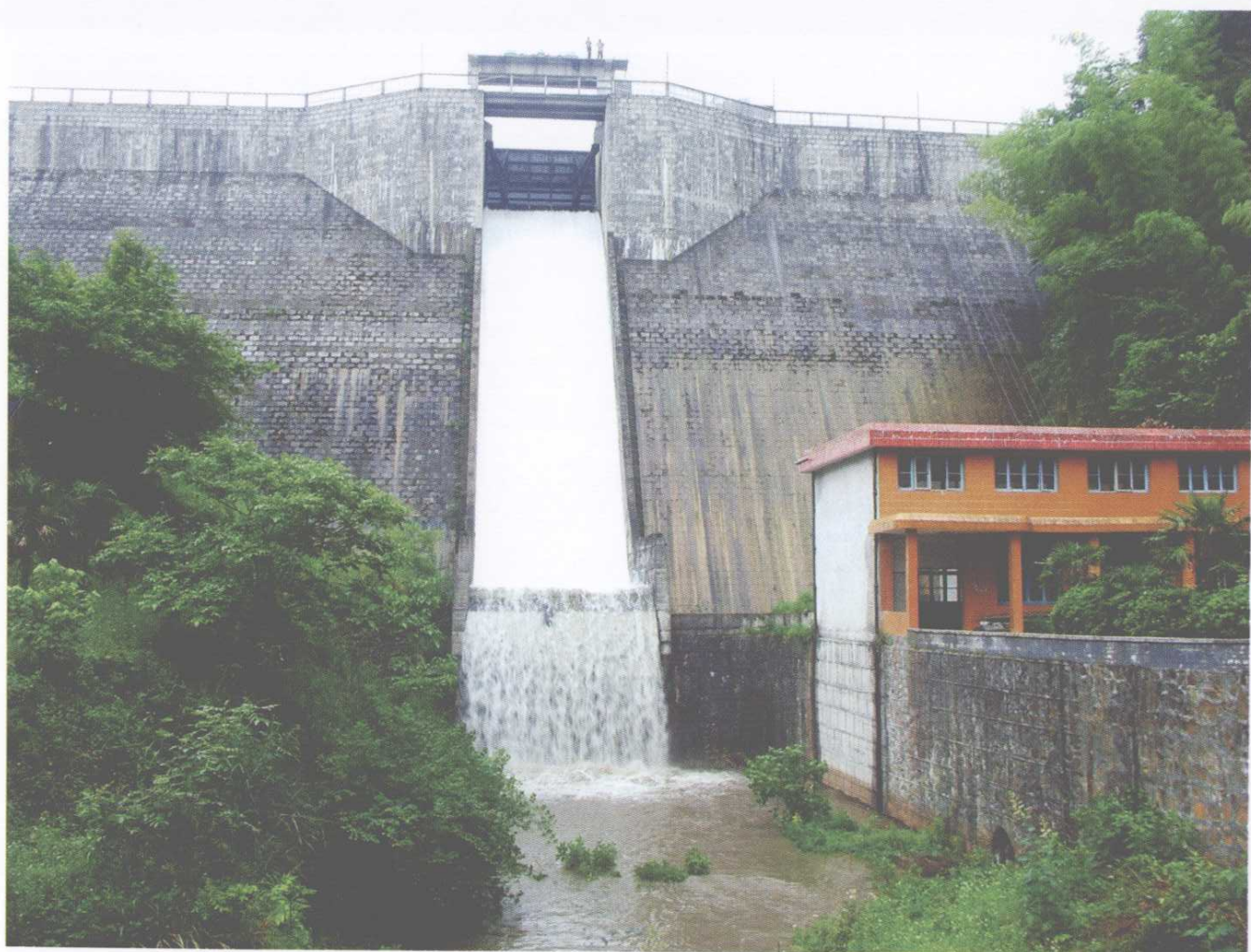
棕树园水电站大坝
