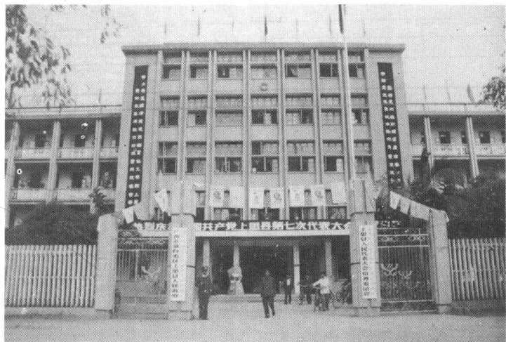
县政府办公大楼
