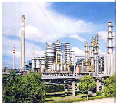
中国石化镇海炼化化工股份有限公司生产装置区一角
