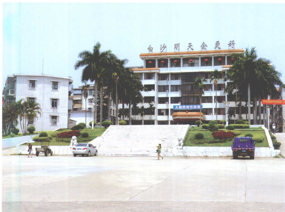
白沙黎族自治县人民政府办公大楼
