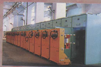
JYN6—10 移开式交流金属封闭开关设备
