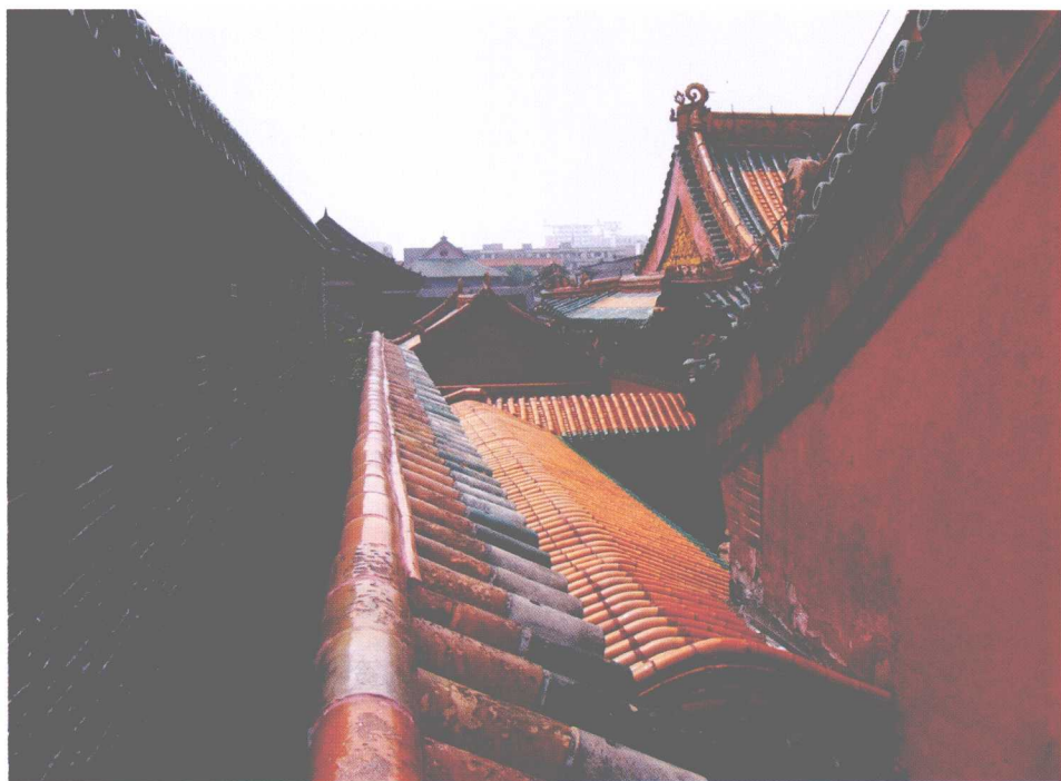
沈阳故宫的砖、瓦、墙
