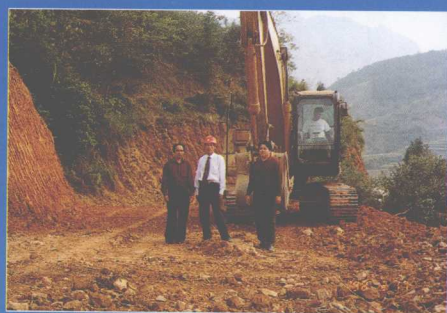
欧家成在新开发的通村四级公路建设工地上
