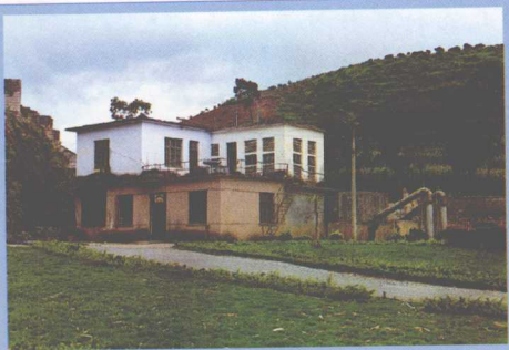
巴马县自来水有限责任公司净化站厂区一角
