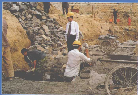
欧家成在学生公寓楼建设工地上检查工程用料
