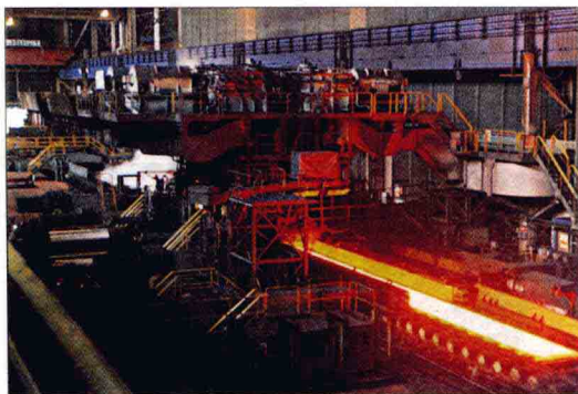
钢铁厂轧钢生产线
