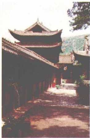
图1-10 金代建筑——山西真泽二仙宫廊房及梳妆楼 (引自《泽州古代文化荟萃》)
