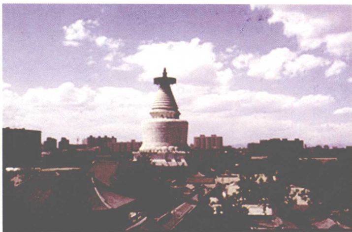
图1-11 元代喇嘛教建筑——北京妙应（白塔）寺
