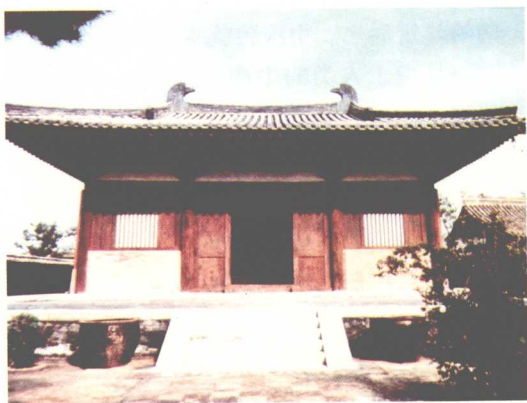
图1-7 唐代建筑——山西五台山南禅寺大殿 (引自《梵宫·中国佛教建筑艺术》)
