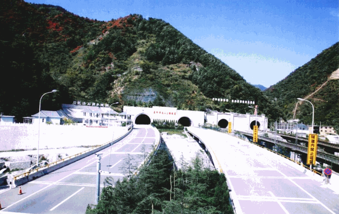
秦岭终南山公路隧道
