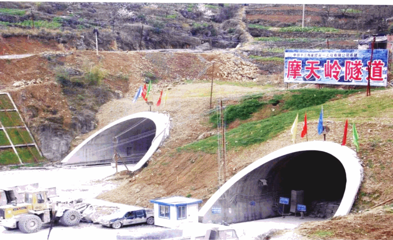
摩天岭隧道进口
