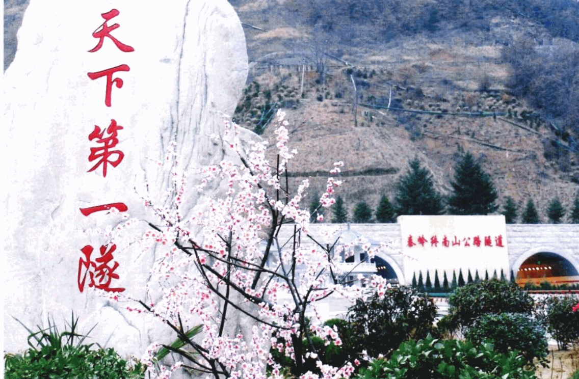
秦岭终南山公路隧道
