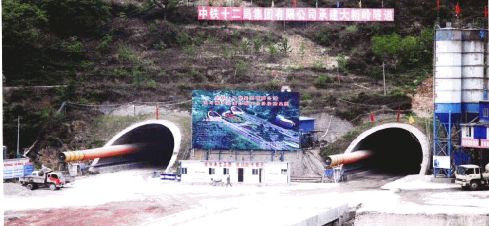
大相岭隧道进口
