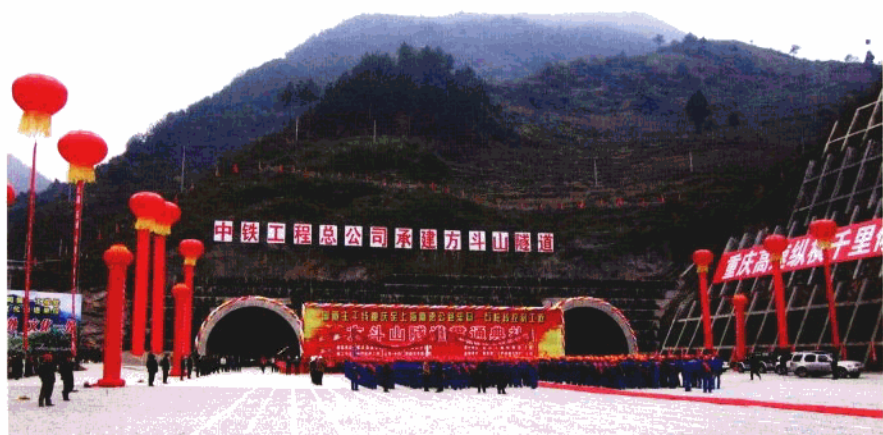
方斗山隧道出口
