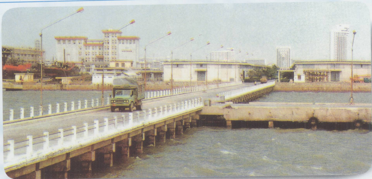
▲ 汕头市东区粮库、面粉厂、港口粮食专用码头
