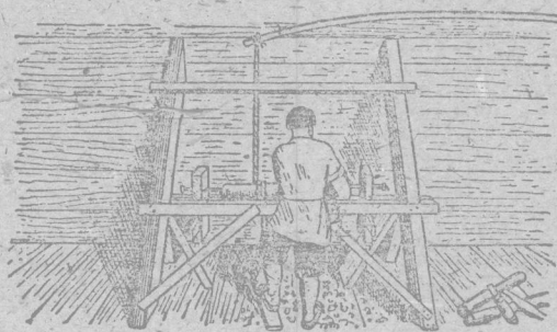
圖 1-1 具有柔軟的桿子和踏板的古老機床。
