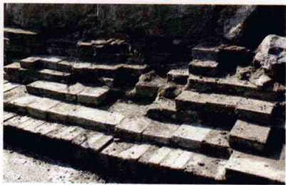
水闸墙外顺势砌筑衬河砖
