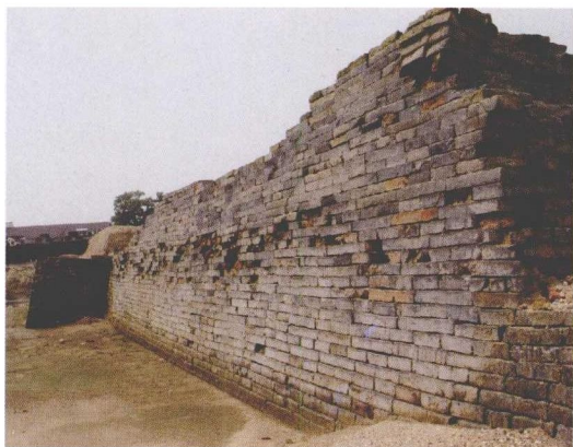
扬州唐罗城南门瓮城城墙。
