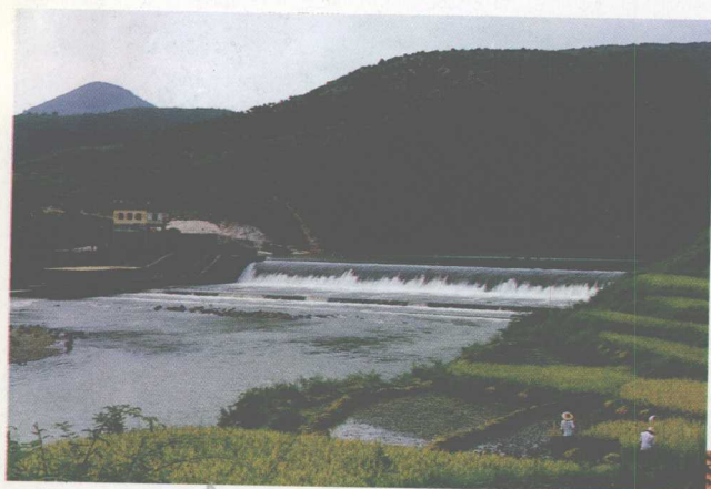
13 灌江引水工程拦河坝 蒋士贵摄
