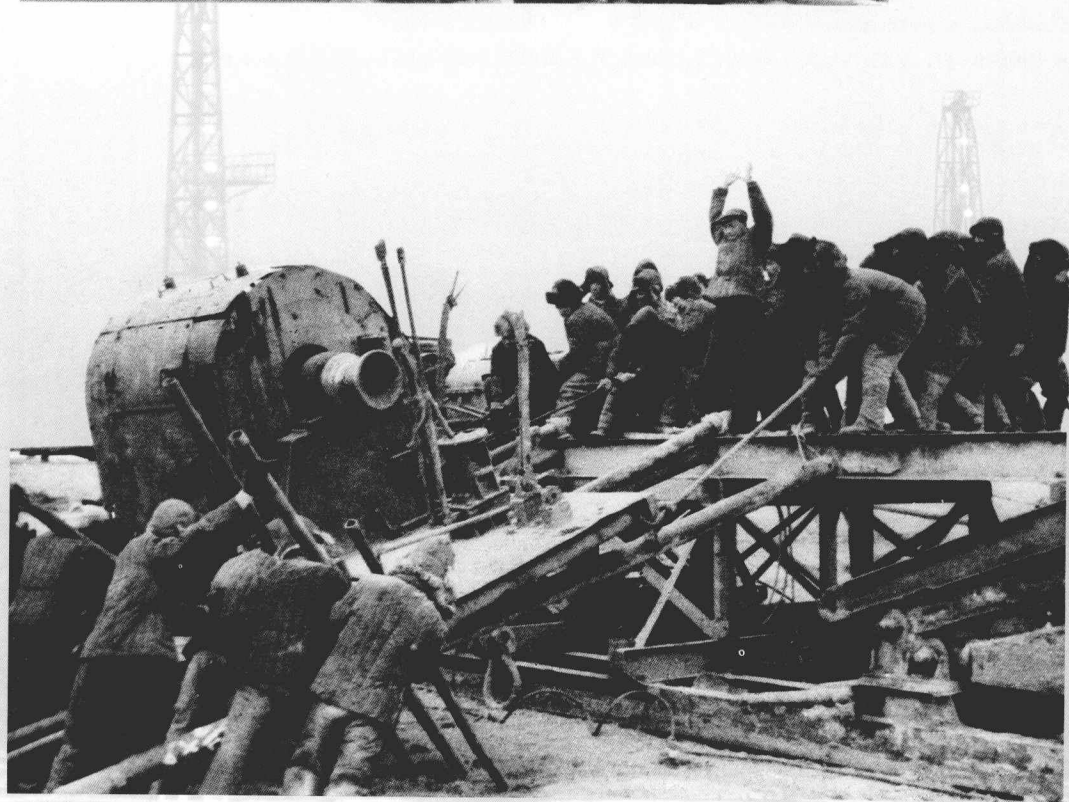
◆ 在没有吊车、拖拉机的情况下，王进喜不等不靠，带领全队用“人拉肩扛”的办法搬运和安装钻机
