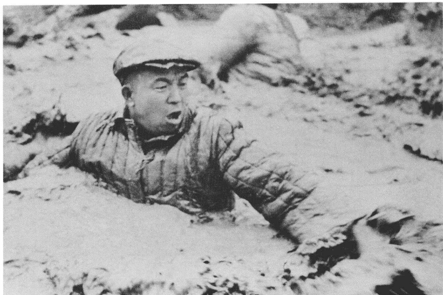
◆在发生井喷的危险时刻，王进喜不顾腿伤，带头跳进泥浆池，用身体搅拌泥浆，压住井喷
