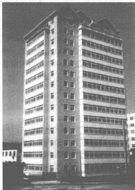
图 1.7 辽宁盘锦 15 层配筋砌块砌体房屋
