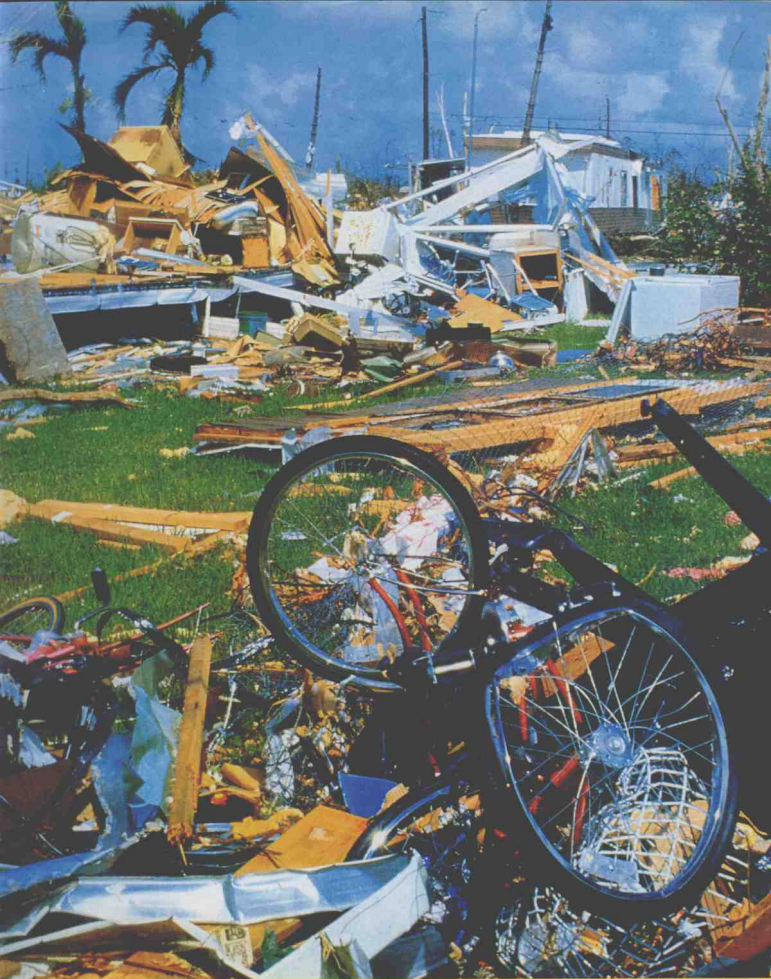
▲这个混乱的地方曾是一排房屋。在一场猛烈的暴风之后,狂风使原来的建筑物变成一片废墟。
