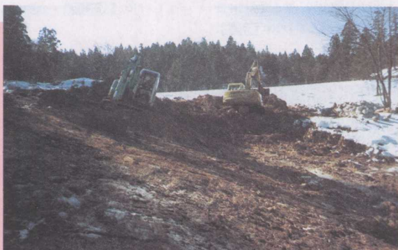
▲ 工程接近完成的水域和土壤。有关施工后的形状以及人们蹂躏的影响等问题，要在施工监理者协商后通知工程机械的操作者
