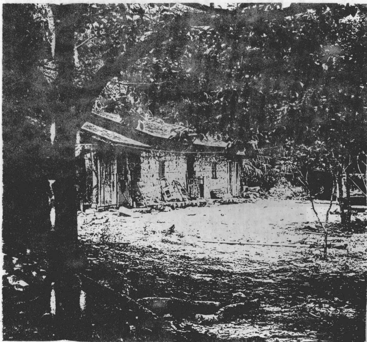
土角厝保留了先人建屋的風貌。
