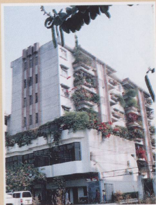
市国土局办公楼
