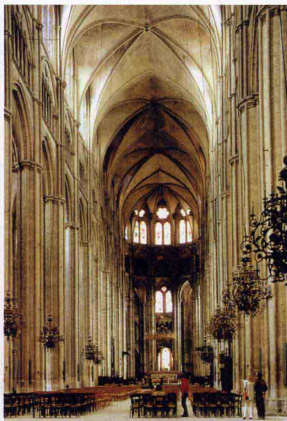
图1-13 法国，布耳日，圣埃蒂安大教堂，1195~1275年，哥特交叉拱顶由外部的飞扶壁支撑，所以能够在高的墙面上开高侧窗，中厅有高耸的特点，两边的侧廊则具有开放流通的特征。
