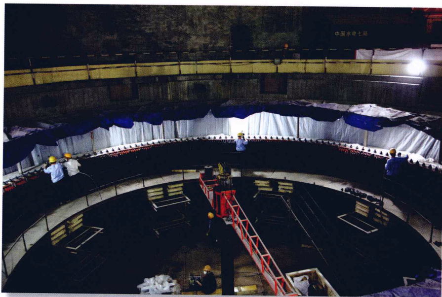
定子铁芯压紧（梁江 摄）
