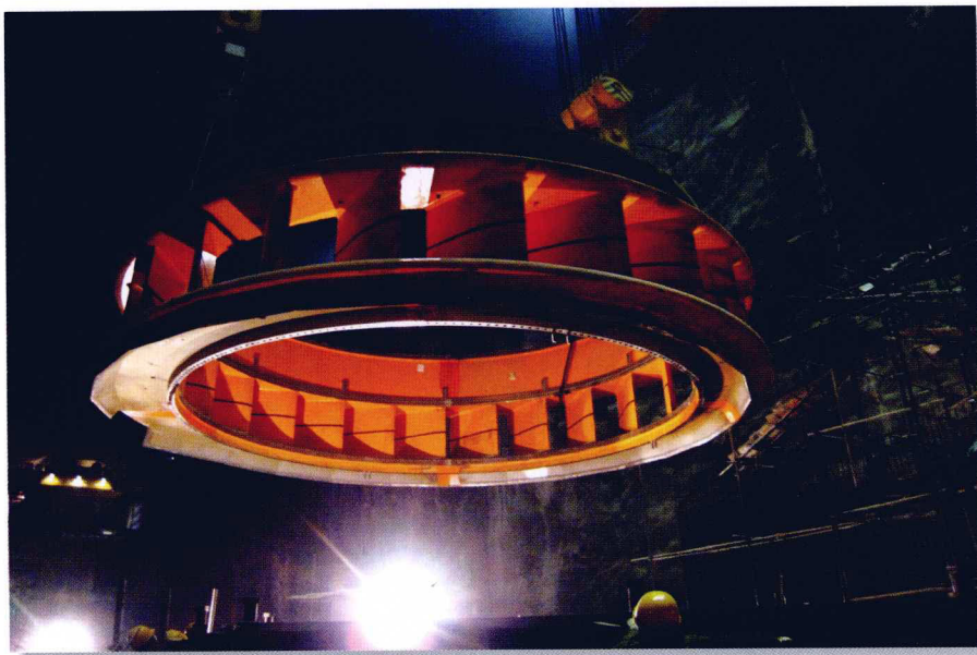
5号机组座环吊装（宋乃奎 摄）
