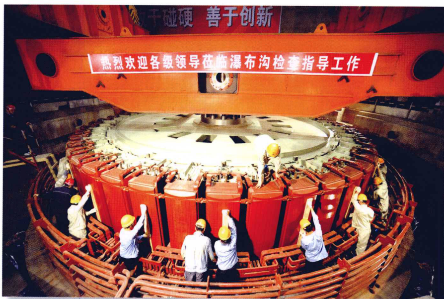
2009年5月瀑布沟6号机组转子吊装 (冉开金 摄)
