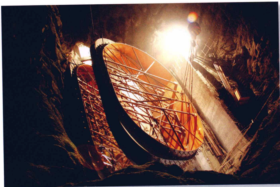
5号机组肘管安装（梁江 摄）
