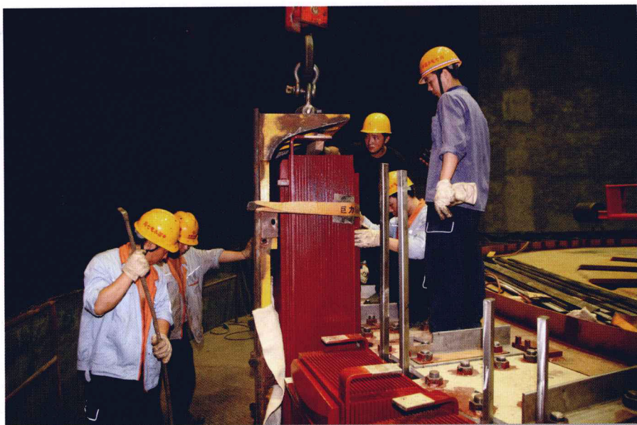
2009年9月瀑布沟5号机组转子磁极挂装（梁江 摄）
