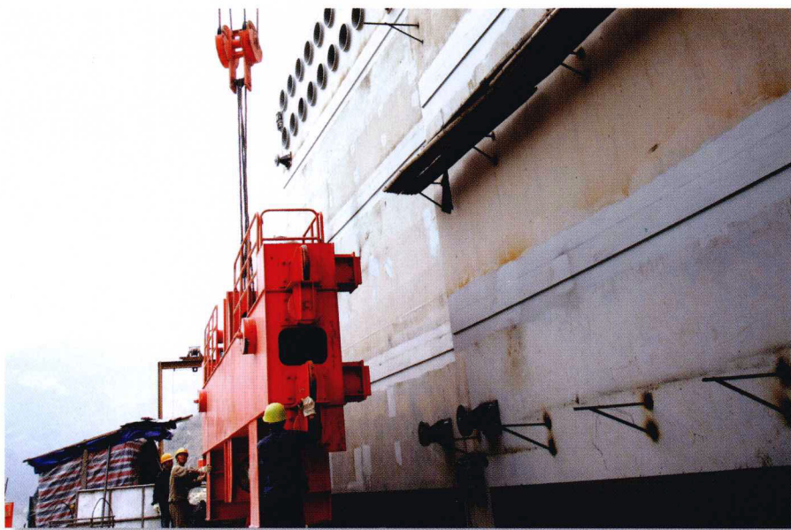
2009年4月厂房进水口金结安装施工（梁江 摄）
