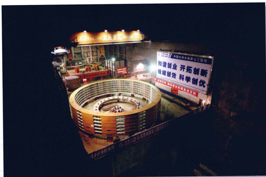
2008年8月瀑布沟5号机组定子机座拼装面貌（梁江 摄）
