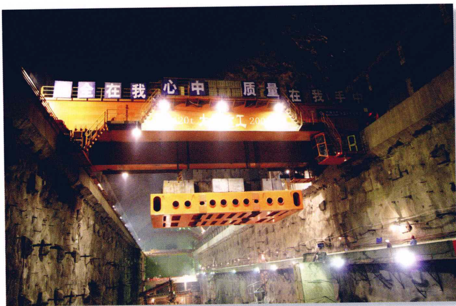
瀑布沟地下厂房岩锚梁荷载试验（梁江 摄）
