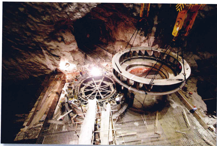
6号机组座环吊装（梁江 摄）
