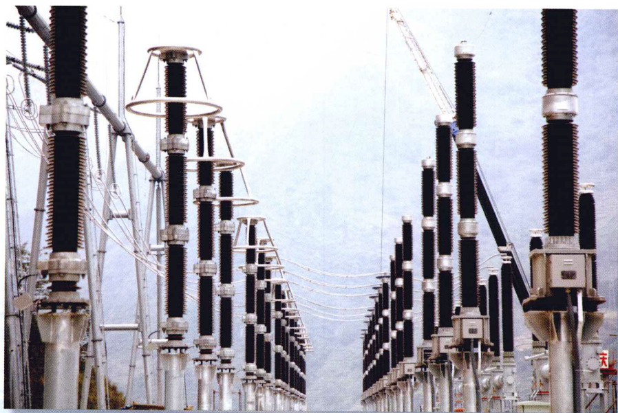
2009年10月开关站高压设备安装（梁江 摄）
