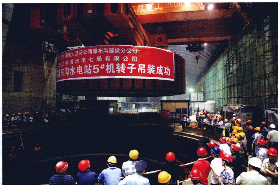
2009年9月瀑布沟5号机组转子吊装（梁江 摄）
