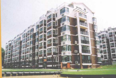
多层住宅实景
