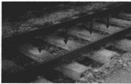
(a) 混凝土枕
